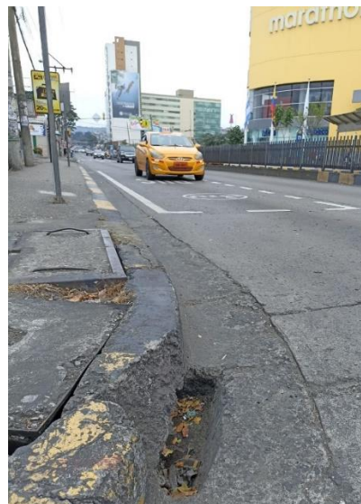
Figura 4 Sumidero tipo buzón al frente de City Mall
