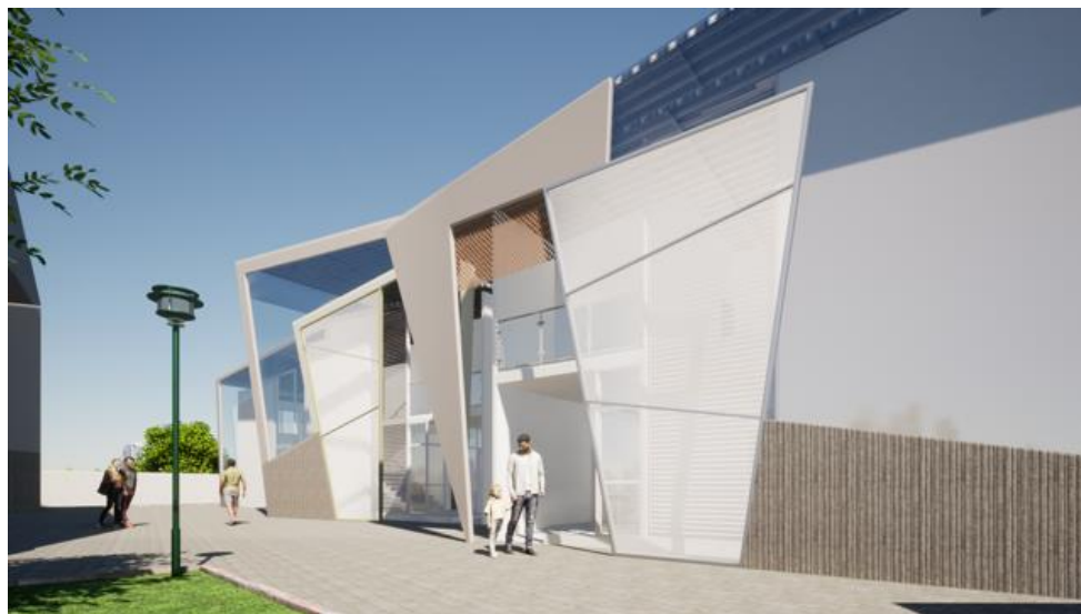
Ilustración 61: Fachada tipología Deconstructivismo Fuente: AutoCAD, 2022 Elaborado por: Gutiérrez, G. y Rivera, G. (2022)
