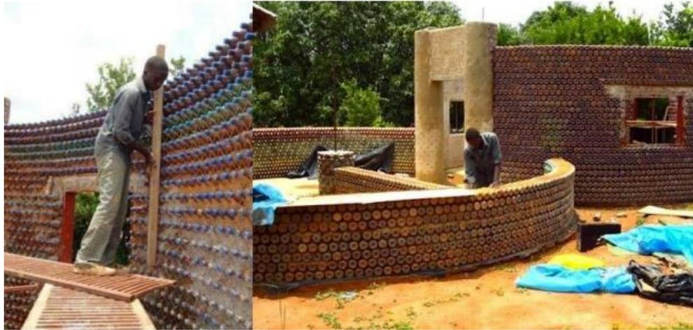
**Figura 2:** Vivienda construida con muros portantes Pet
