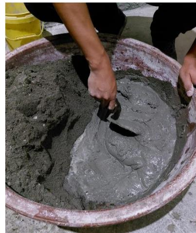
**Figura 29:** Preparación de mortero con cemento, arena y agua
