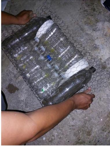
**Figura 30:** Ubicación de botellas plásticas vertical, malla metálica para elaboración de bloque (A)
