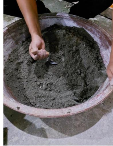
**Figura 17:** Material para mortero, cemento, arena, agua
