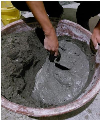
**Figura 18:** Preparación de mortero para recubrimiento de bloque con botellas plásticas
