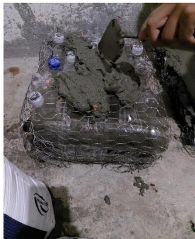
**Figura 20:** Recubrimiento de mortero para bloque con botellas plásticas con malla metálica (A)
