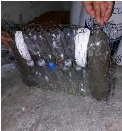
**Figura 31:** Ubicación de botella plástica vertical, malla metálica para elaboración de bloque (B)
