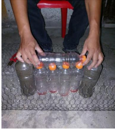
**Figura 19:** Preparación de bloque con botellas plásticas con malla metálica
