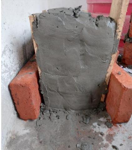
**Figura 22:** Elaboración del bloque con mortero, botellas plásticas, malla metálica (A)
