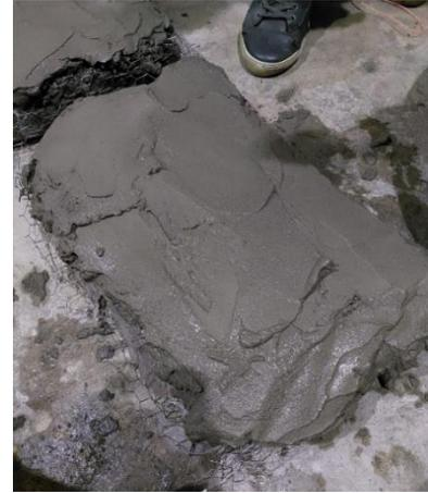
**Figura 21:** Recubrimiento de mortero para bloque de botellas plásticas con malla metálica (B)
