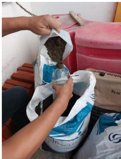
**Figura 27:** Arena para llenar botellas de plástico en la elaboración de bloques
