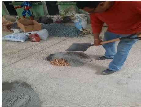
Foto 22. Elaboración de la mezcla Elaborado por: Carpio y Villon (2023)
