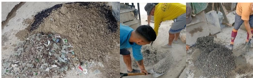
Figura 29: Mezcla manual de los materiales Elaborado por: Flores, G. y Tenesaca, J. (2022)
