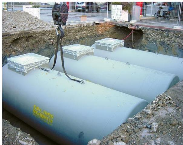
Figura 9 Tanques enterrados
