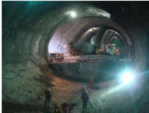
Figura 2. Proceso constructivo subterráneo.
