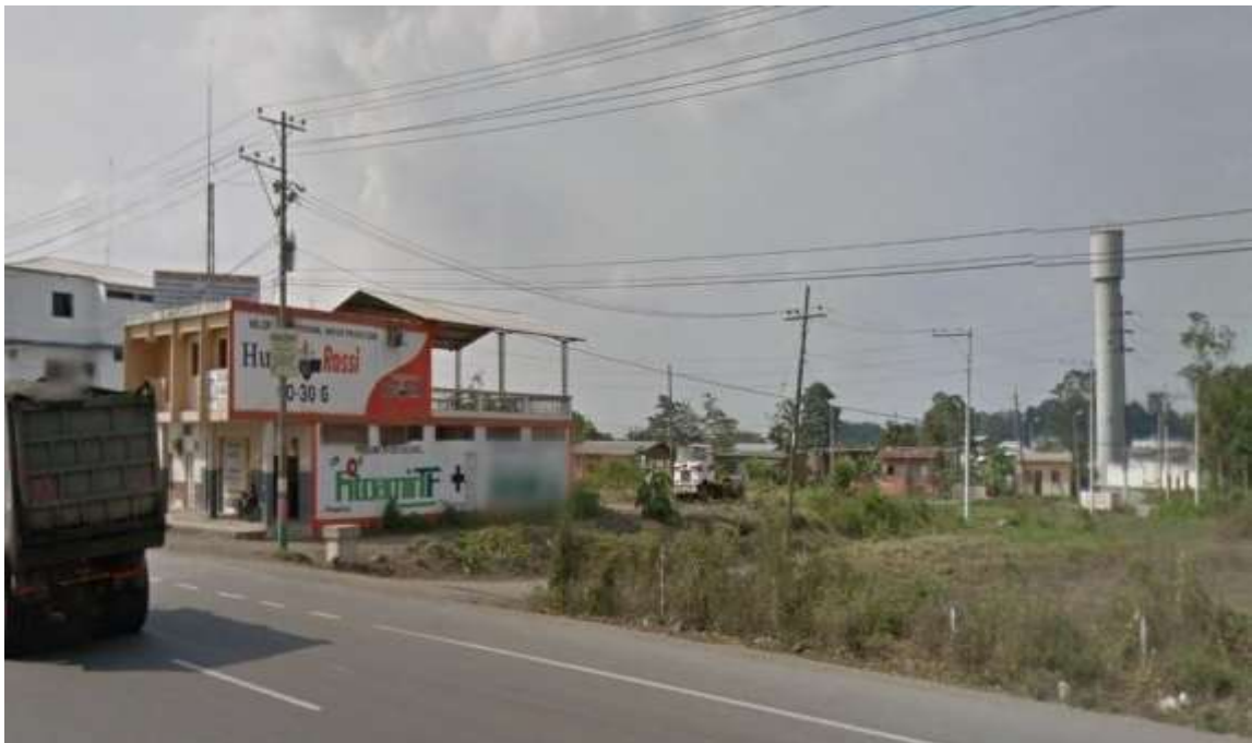
Ilustración 37. Infraestructura de la zona de estudio Fuente: Google Street View
