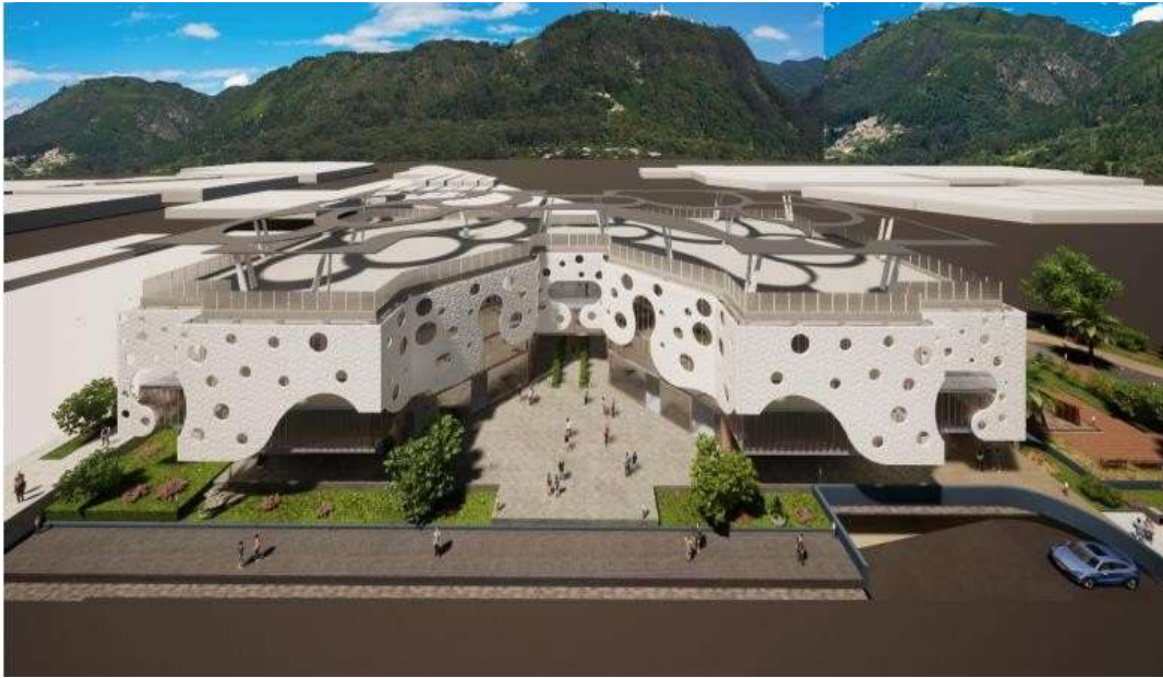
Ilustración 3. Fachada de centro empresarial avenida Américas Fuente: Quiroja, (2021).
