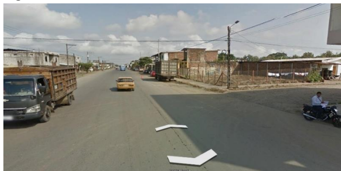
Figura 120. Situación actual – Inexistencia de aceras
