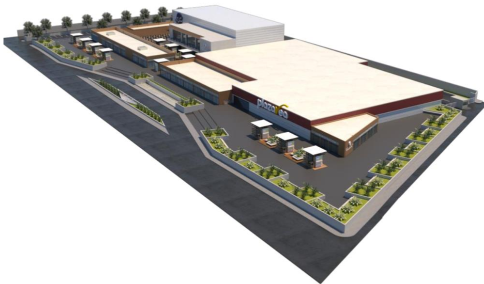
Figura 21. Vista aérea de proyecto de centro comercial tipo strip.
