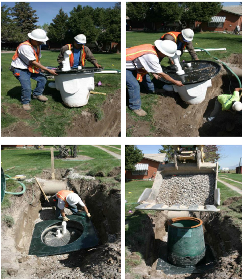
Figura 47. Instalación de Cámaras de Vacío Domiciliarias
