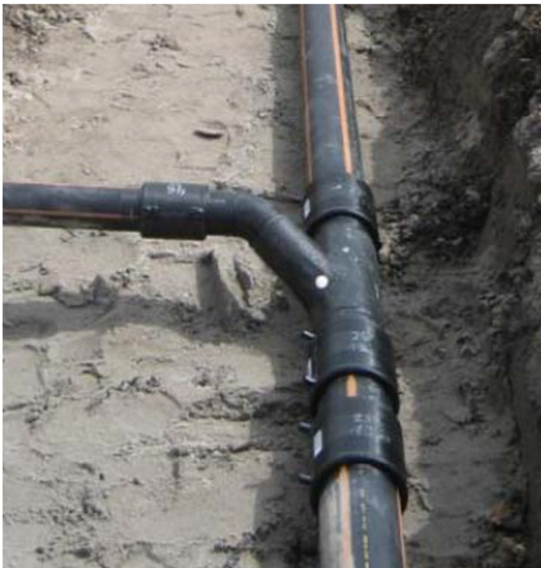
Figura 56. Conexión a Tubería de Red de Vacío Principal
