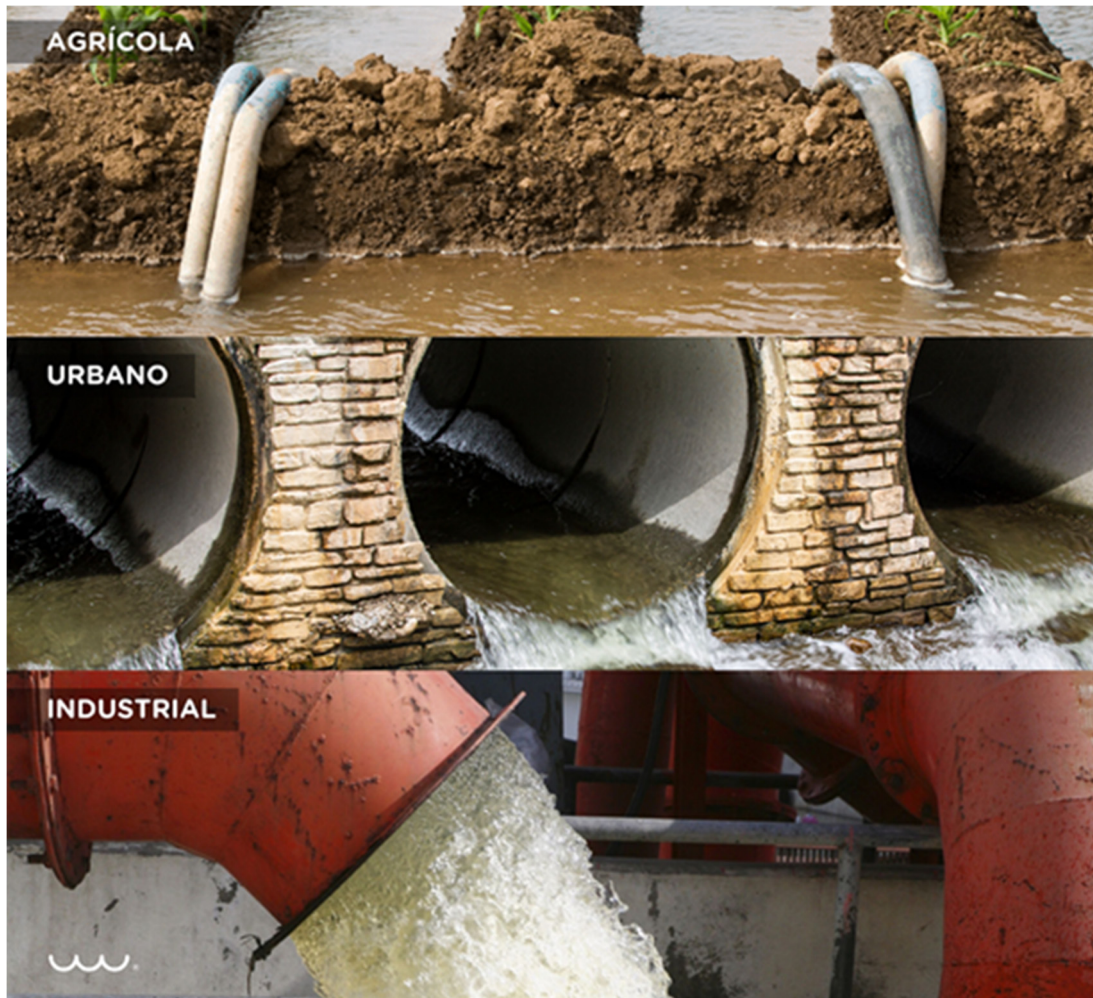
Figura 7. Origen de las Aguas Residuales
