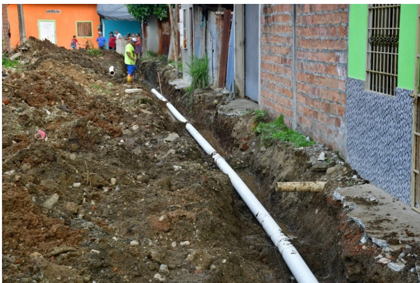
Figura 3. Trabajos de instalaciones de alcantarillado sanitario
