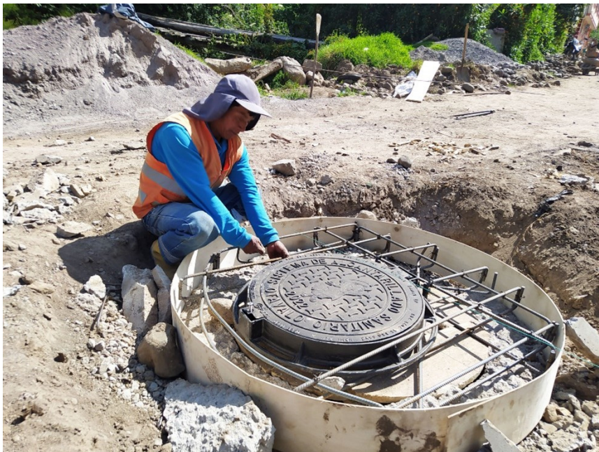
Figura 48. Construcción de Cámaras Colectora por Gravedad
