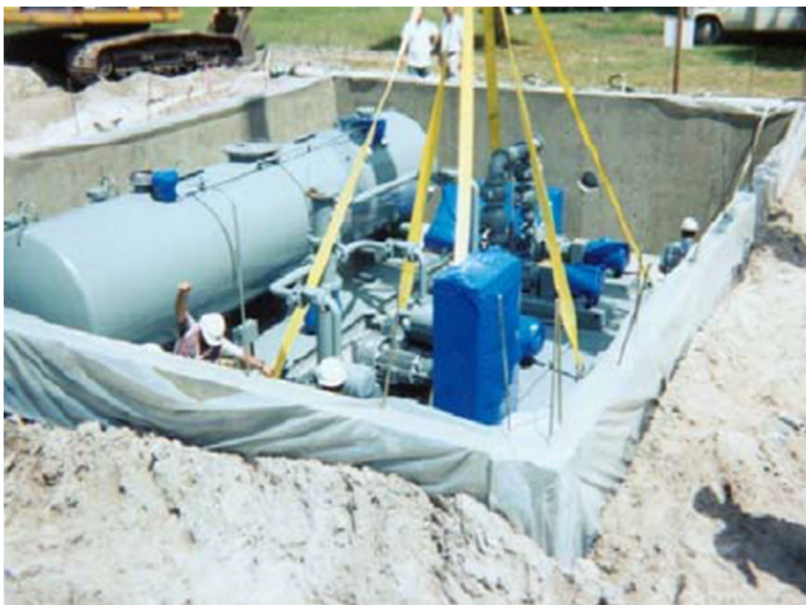
Figura 50. Montaje de una Estación de Vacío
