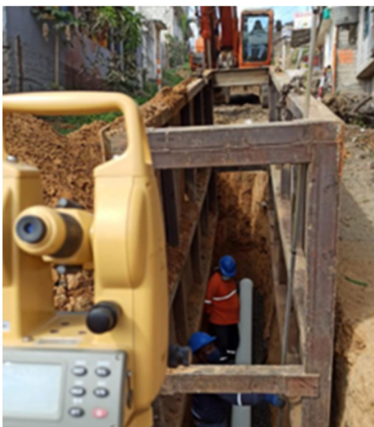
Figura 10. Construcción de Redes de Alcantarillado Sanitario
