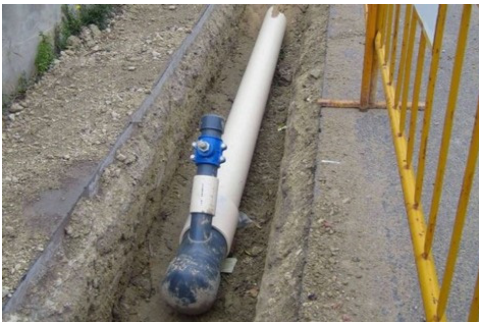
Figura 20. Trabajos de instalación del sistema de vacío
