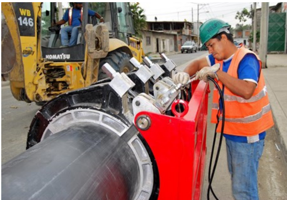
Figura 12. Colector de Aguas Servidas
