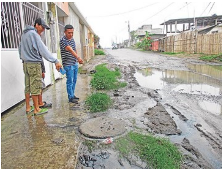
Figura 49. Rebose de Aguas Servidas
