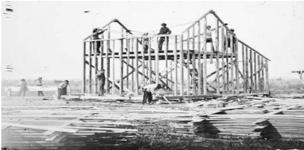
Gráfico 4 Sistema Ballon Frame
