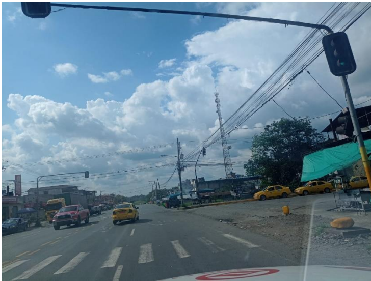
Semáforos en mal estado
