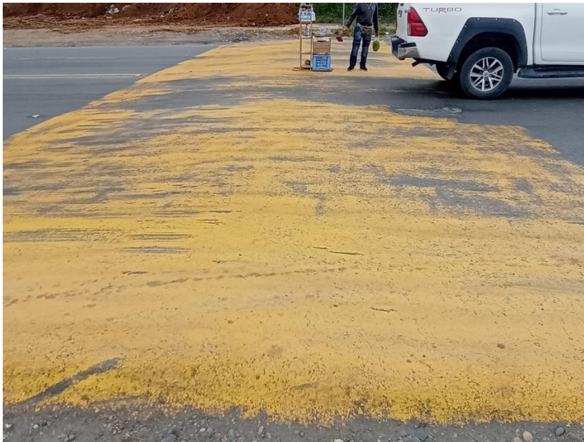
Señalética de zona escolar mal ubicada
