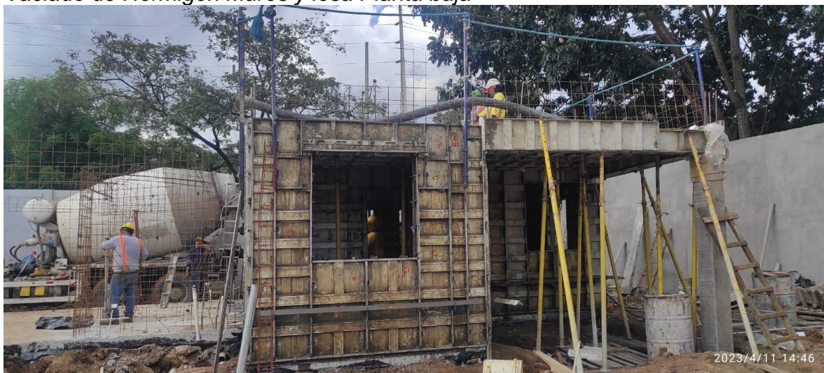
Vaciado de Hormigón Muros y losa Planta baja
