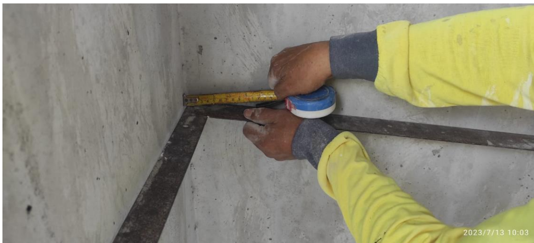
Revisión de escuadra entre muros
