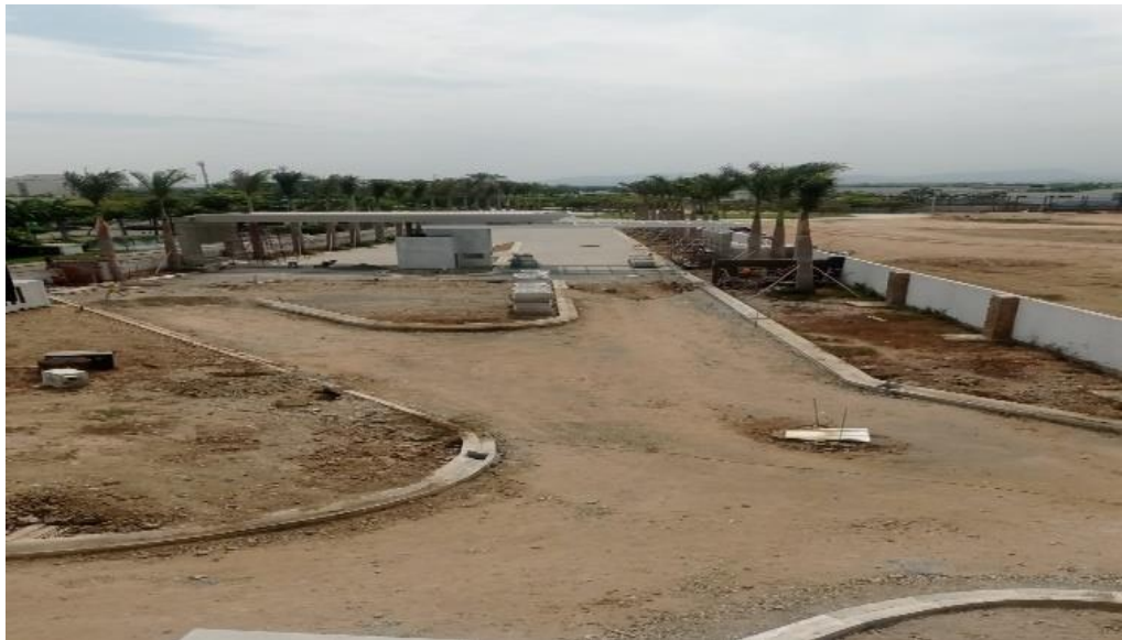
Figura 20: Inicio de Obra - construcción de las áreas verdes
