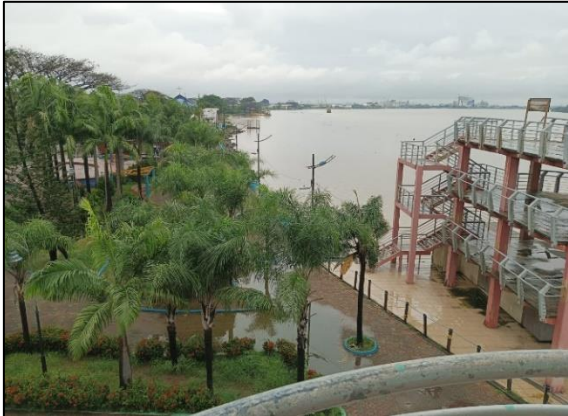
Figura 109. Actual paso desnivel que conecta la isla Santay con el malecón
