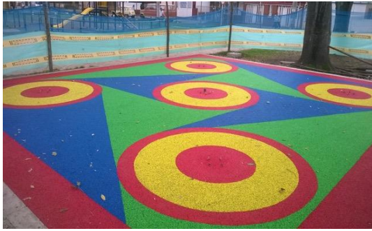
Ilustración 115. Piso de caucho continuo
