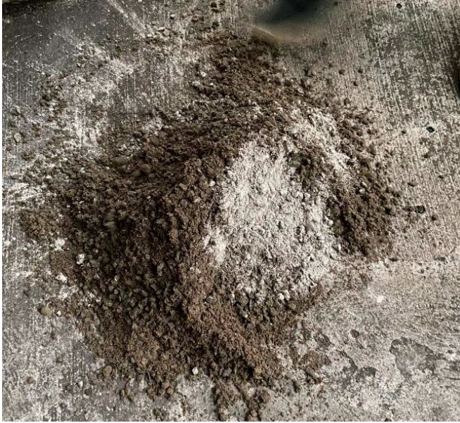
Figura 28: Mezclar la arena, piedra #18 y cemento para el Prototipo PTYH 01.
