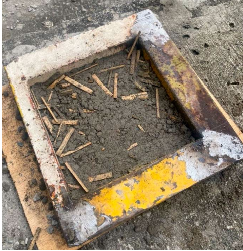
Figura 33: Encofrado para el Prototipo PTYH 02.
