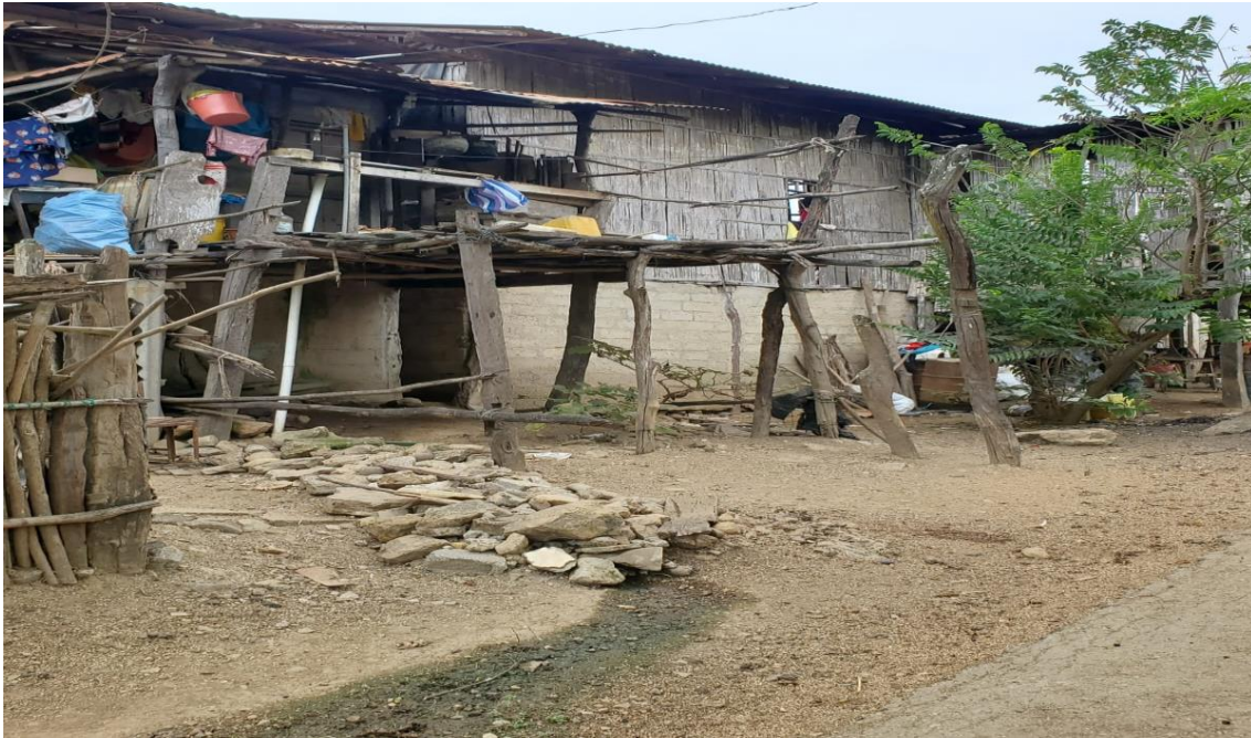
Figura 19 Vivienda común del sector Sube y Baja
