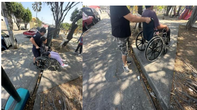
Ilustración 35. Entradas sin rampas
