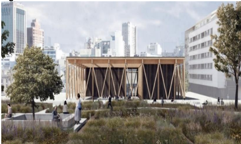
Figura 7. Pilares de madera en forma de V
