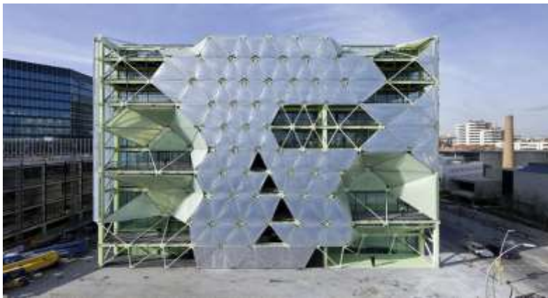
Ilustración 37. Fachada con unión de formas, que generan sombra.
