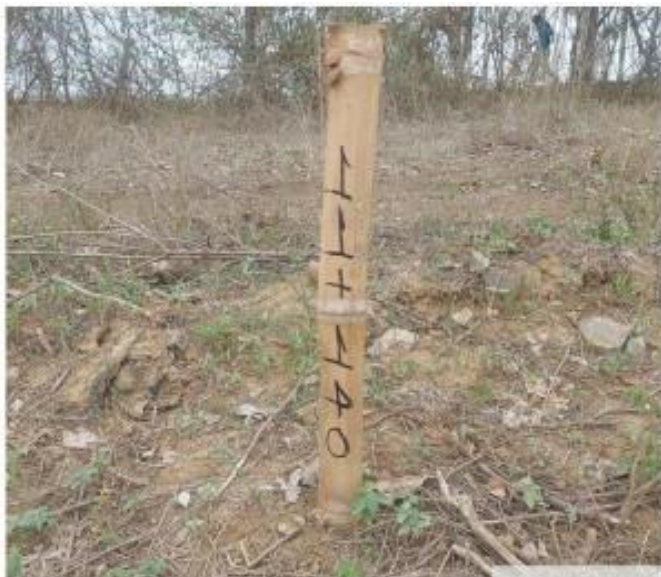
Figura 21 Colocación de balizas
