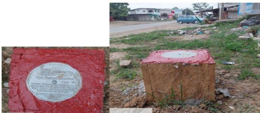
Figura 19 Hito de Hormigón Hidráulico
