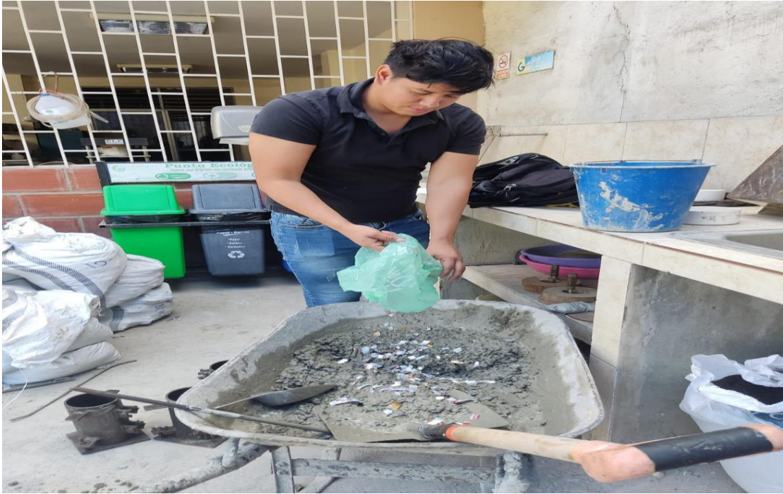
Figura 17 Aplicación de fibras de acero
