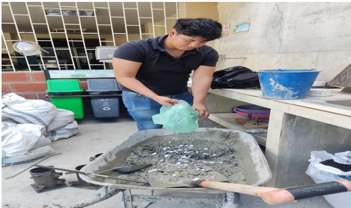
Figura 4 Aplicación de fibras de acero
