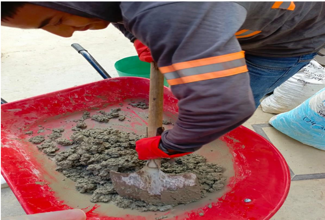
Figura 18 Aplicación de fibras de aluminio reciclado
