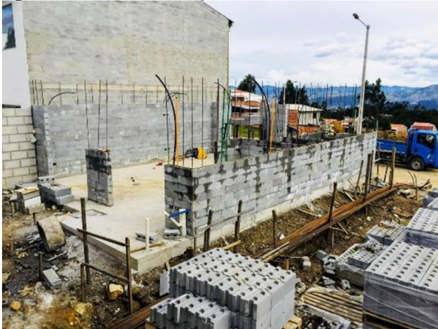
Figura 46: Colocación de bloque sobre losa de cimentación de sistema boonker (2)
