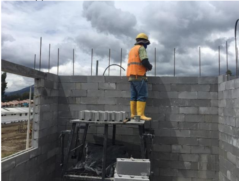
Figura 47: Colocación de bloque para conformar paredes sobre losa de cimentación sistema boonker (3)
