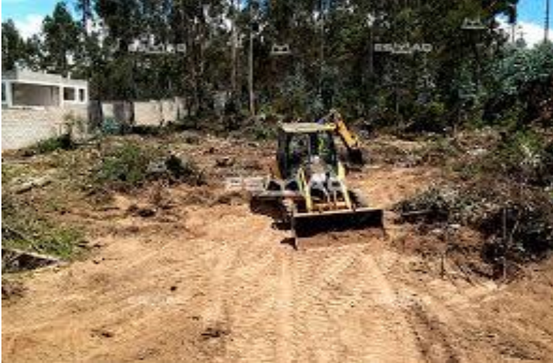
Figura 40: Limpieza del terreno
