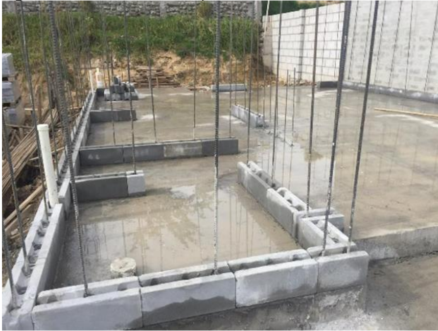
Figura 45: Colocación de bloque sobre losa de cimentación
