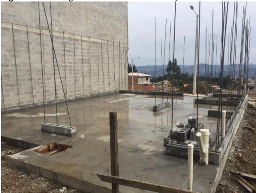
Figura 44: Hormigón en losa de cimentación, sistema Boonker
