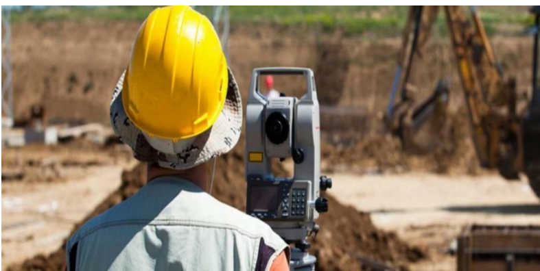
Figura 41: Trazado y replanteo
