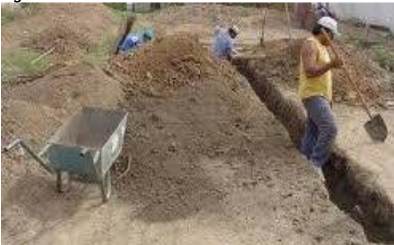
Figura 42: Excavación de cimientos
