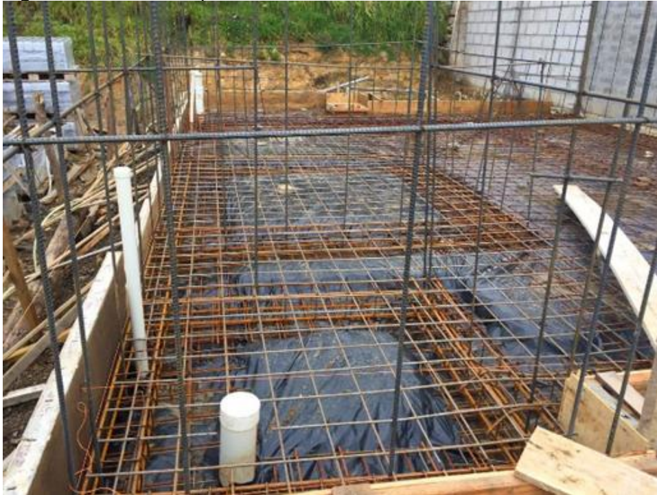
Figura 43: Estructura para losa de cimentación sistema boonker
