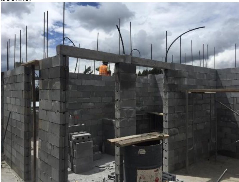
Figura 48: Colocación de bloques para paredes internas, sobre losa de cimentación - sistema boonker
