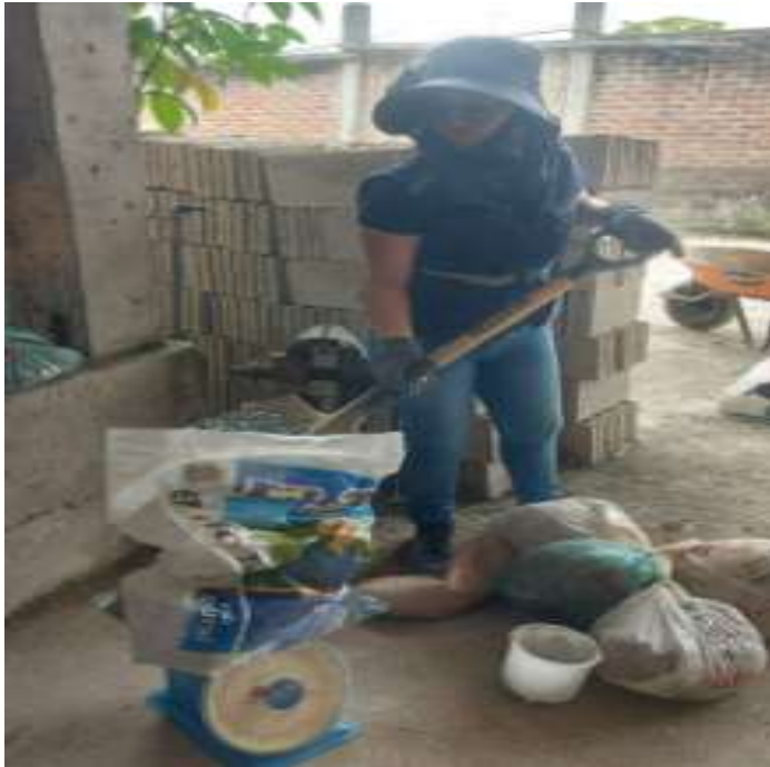
Figura 10: Pesaje del agregado grueso
