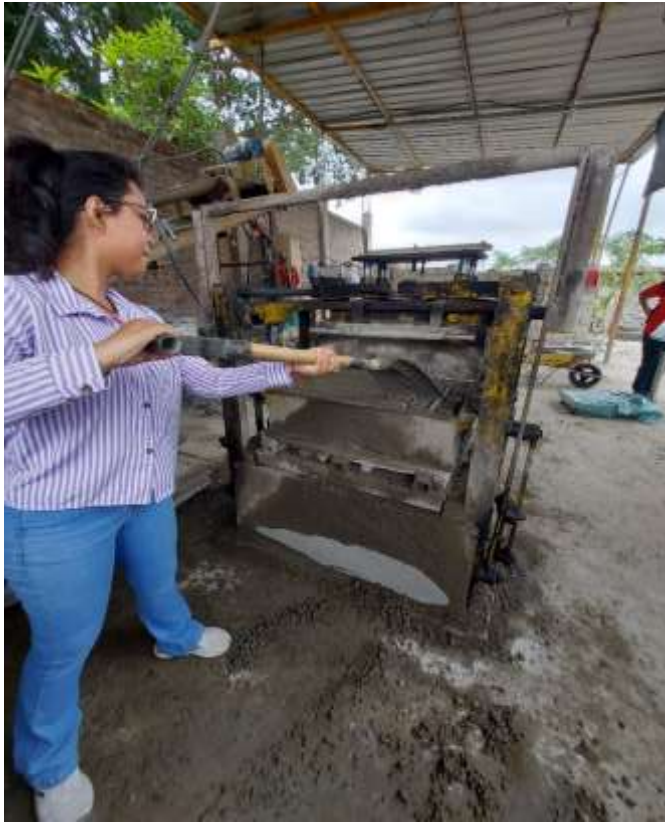
Figura 13: Carga de la mezcla en la máquina vibro compactadora
