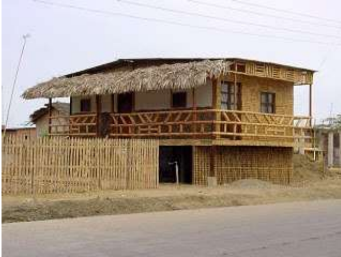
Ilustración 6 Construcción con caña guadua
