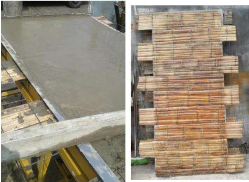
Ilustración 10 Ensamblado de panel
