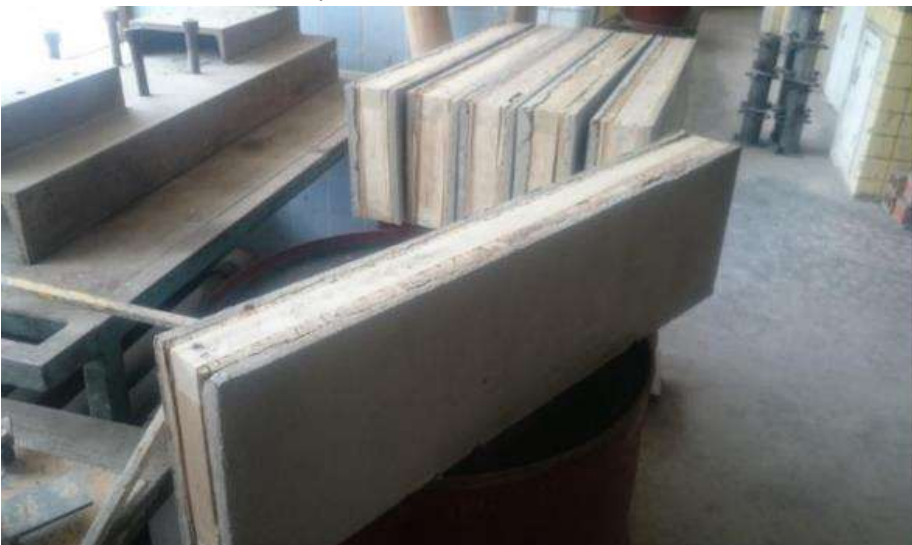
Ilustración 13 Armado de panel terminado
