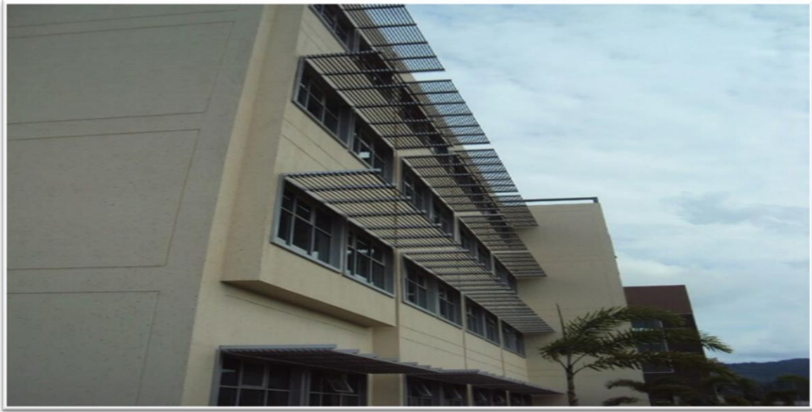
Gráfico 3 Queiebrasoles en la fachada sur del Hospital General de Monte Sinaí
