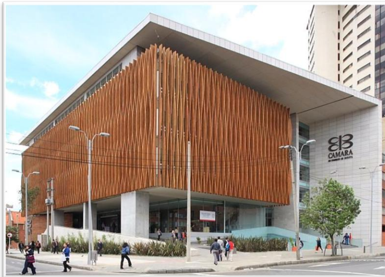
Gráfico 11 Quiebrasoles en fachadas del edificio Cámara de Comercio en Bogotá
