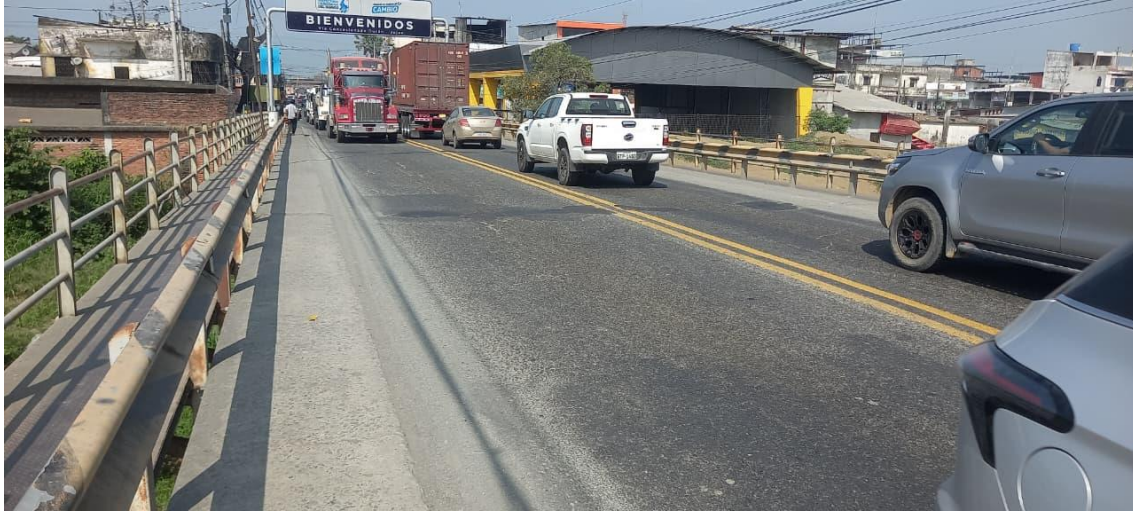
Anexo 5. Registro fotográfico de la inspección técnica in situ en el puente Gemelo.
