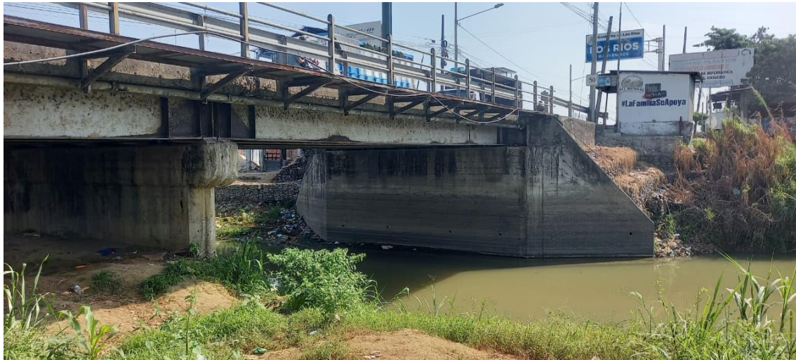
Figura 2. Vista lateral del estribo y pila, margen izquierda del puente.
