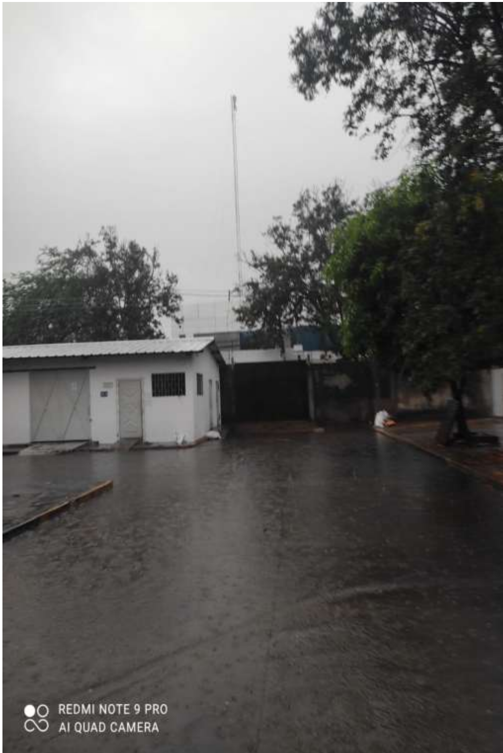
Figura 29.Sistema de drenaje con estancamientos de aguas
