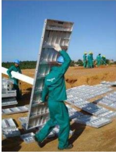
Figura 12: Sistema Manoportable de Paneles Modulares
