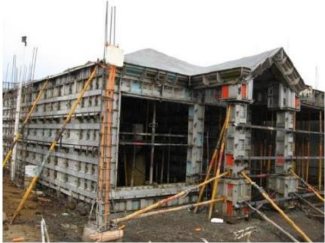
Figura 13: Sistema Manoportable para la Construcción de Viviendas Unifamiliares de Concreto
