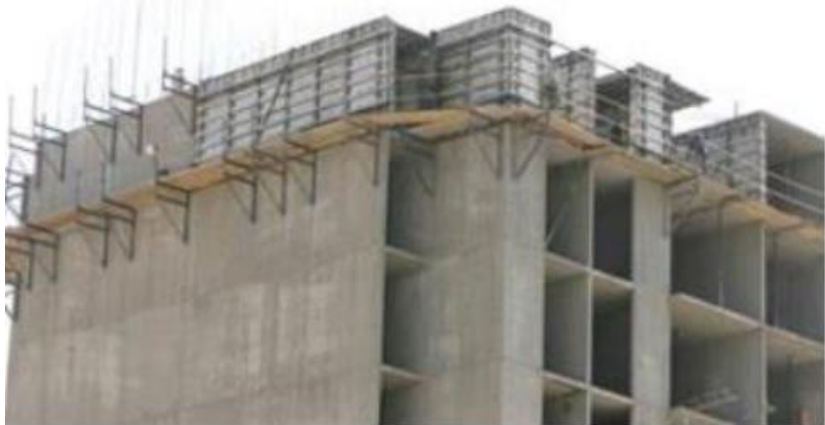
Figura 14: Sistema Manoportable para la Construcción de Viviendas Multifamiliares de Concreto
