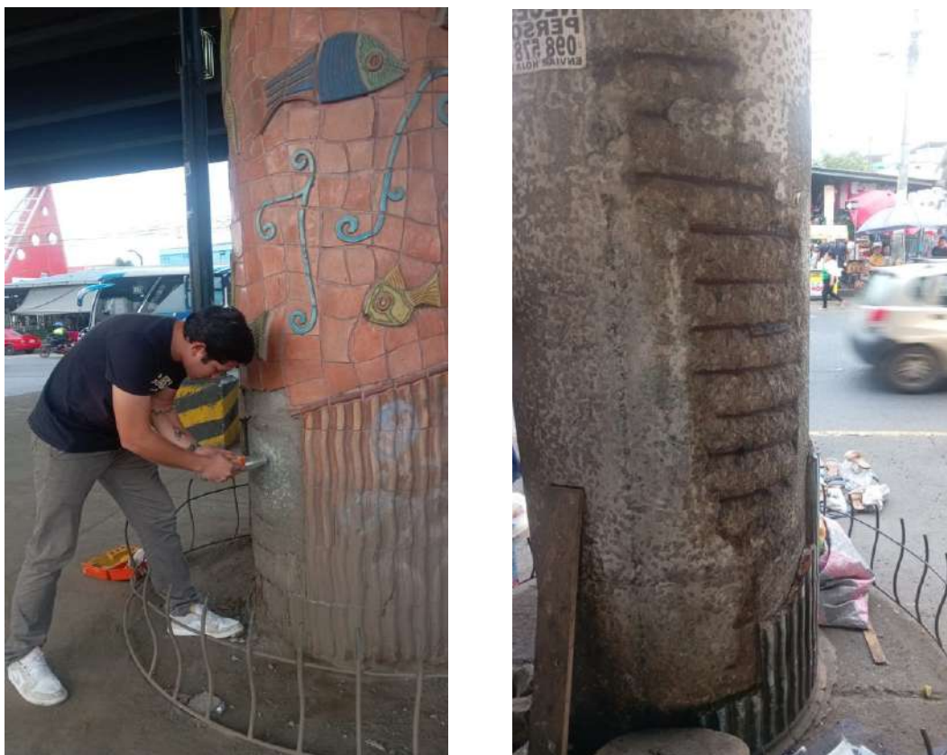
Ilustración 91 Ensayo esclerométrico pilares 5, 6
