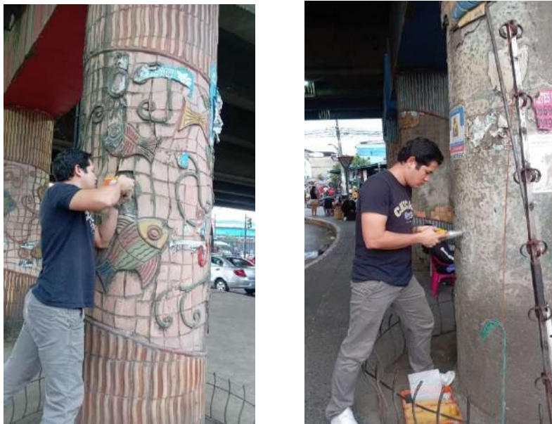
Ilustración 90 Ensayo esclerométrico pilares 2, 3
