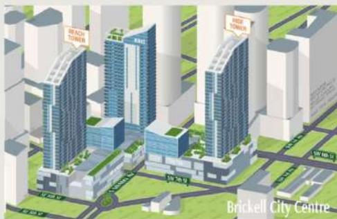
La pieza central es el Climate Ribbon™, una construcción arquitectónica ondulada y en altura que guía las corrientes de aire del sureste, frecuentes en Miami. Esto facilita la ventilación natural en las zonas comunes del centro comercial y disminuye el uso del aire acondicionado.
