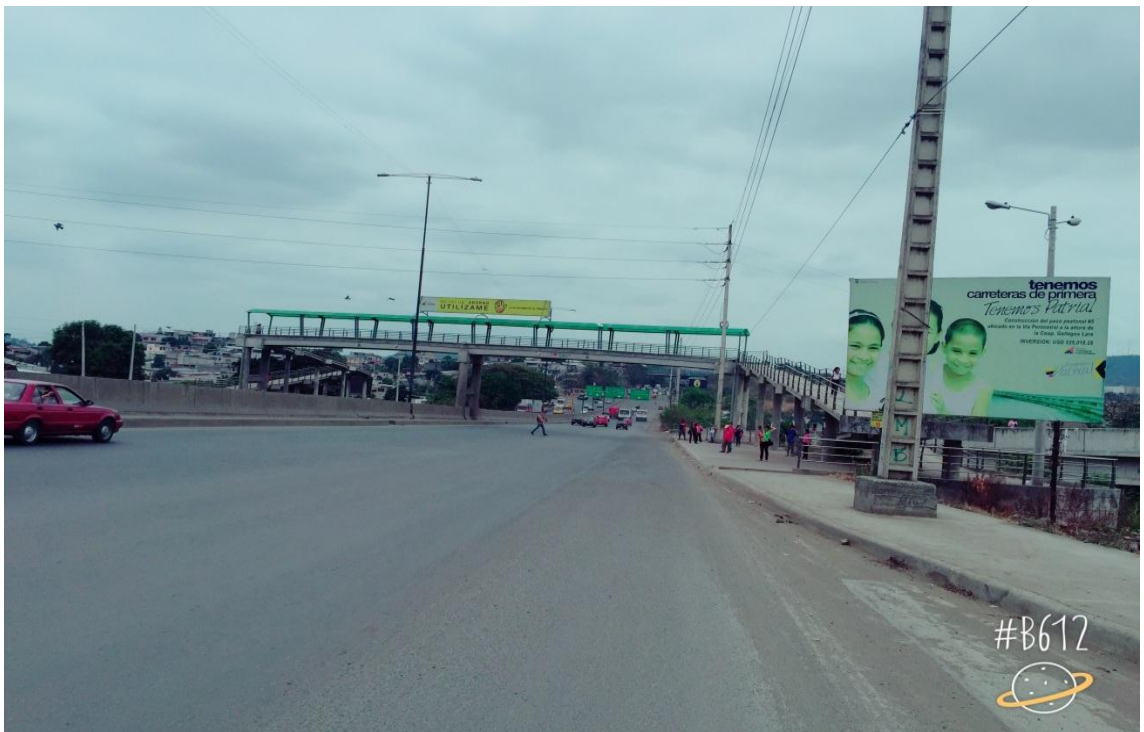
IMPRUDENCIA DE PEATONES PÁSO ELEVADO A LA ALTURA DEL GOE EN SENTIDO NORTE HACIA EL SUR.
