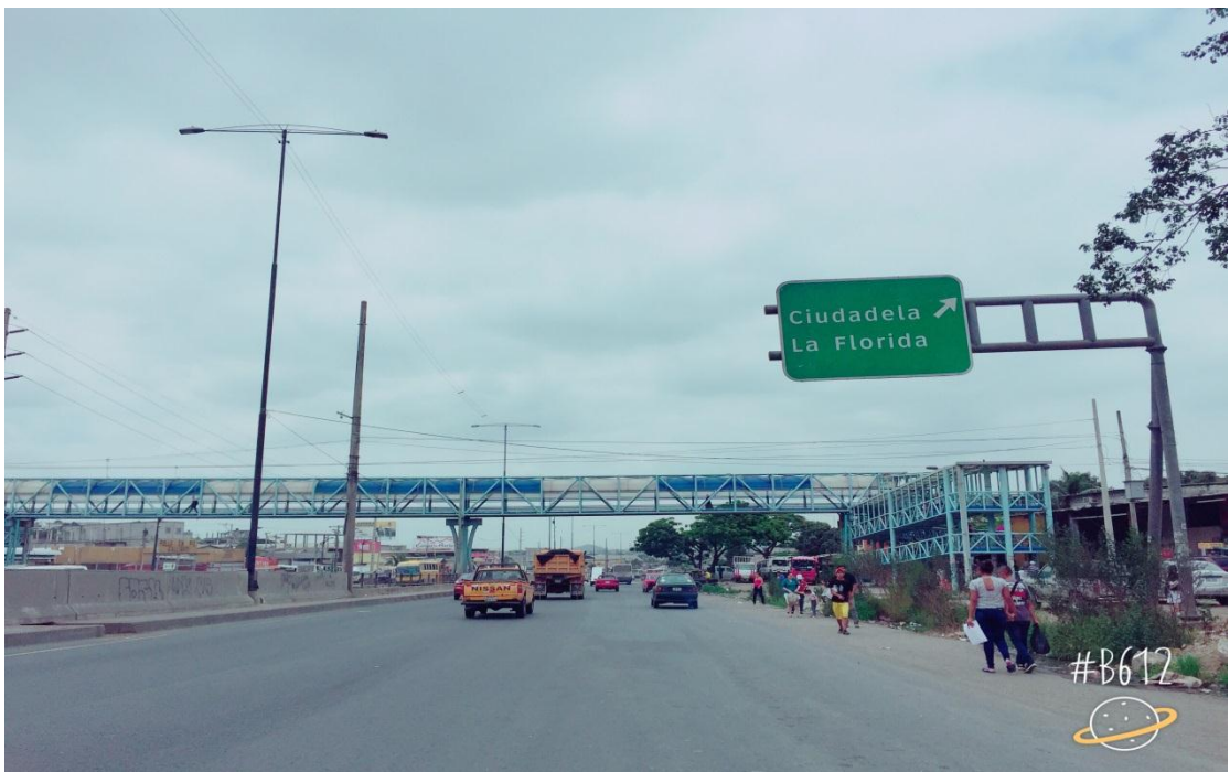
PASO PEATONAL DE LA VIA PERIMETRAL A LA ALTURA DE LA ENTRADA DE LA LINEA 21 EN SENTIDO SUR HACIA EL NORTE.
