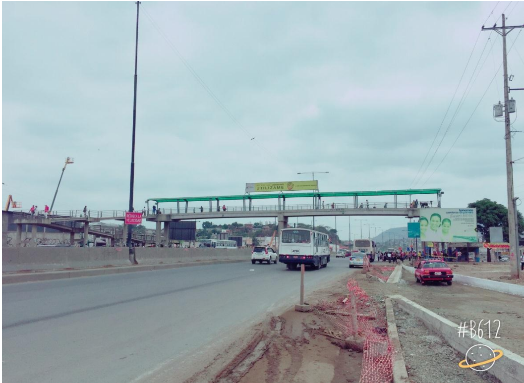
PASO PEATONAL DE LA VIA PERIMETRAL A LA ALTURA DEL CENTRO COMERCIAL EL FORTIN EN SENTIDO NORTE HACIA EL SUR.
