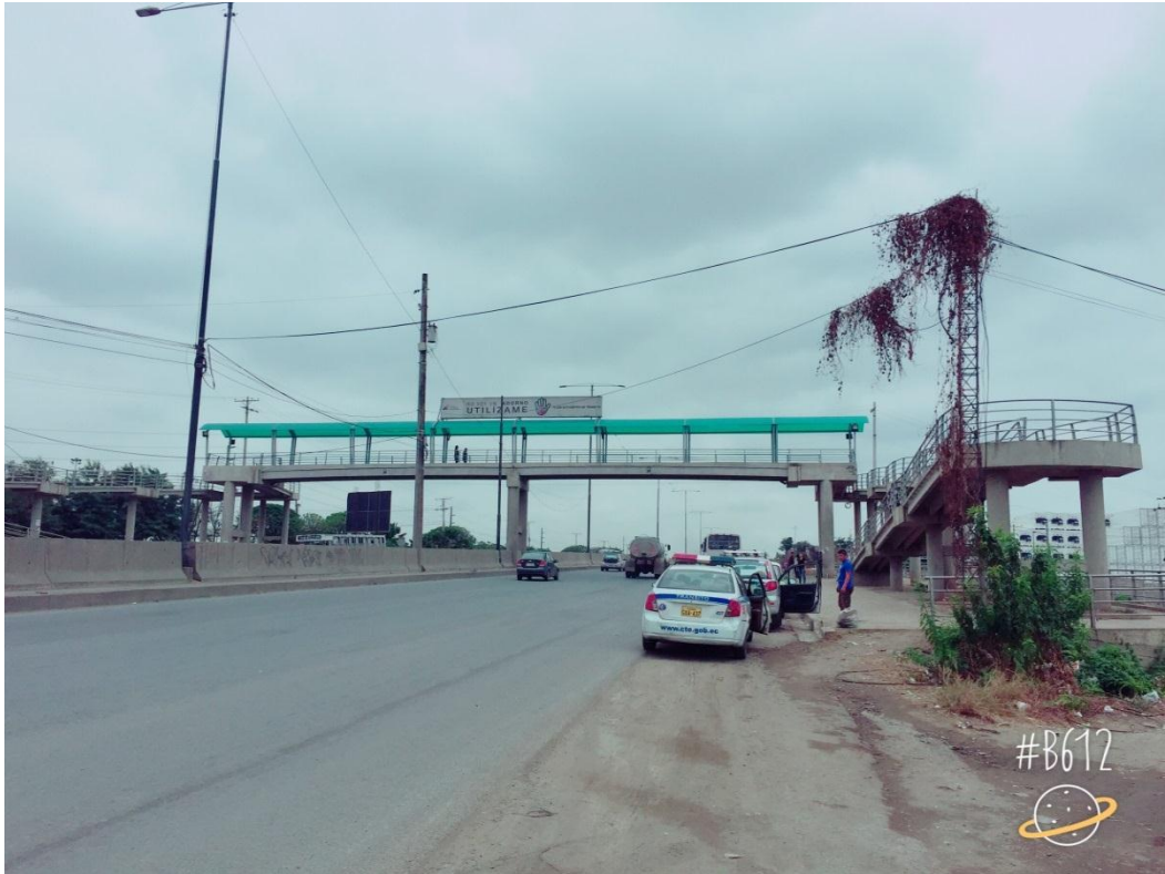
PASO PEATONAL DE LA VIA PERIMETRAL A LA ALTURA DEL HOSPITAL UNIVERSITARIO EN SENTIDO NORTE HACIA EL SUR.
