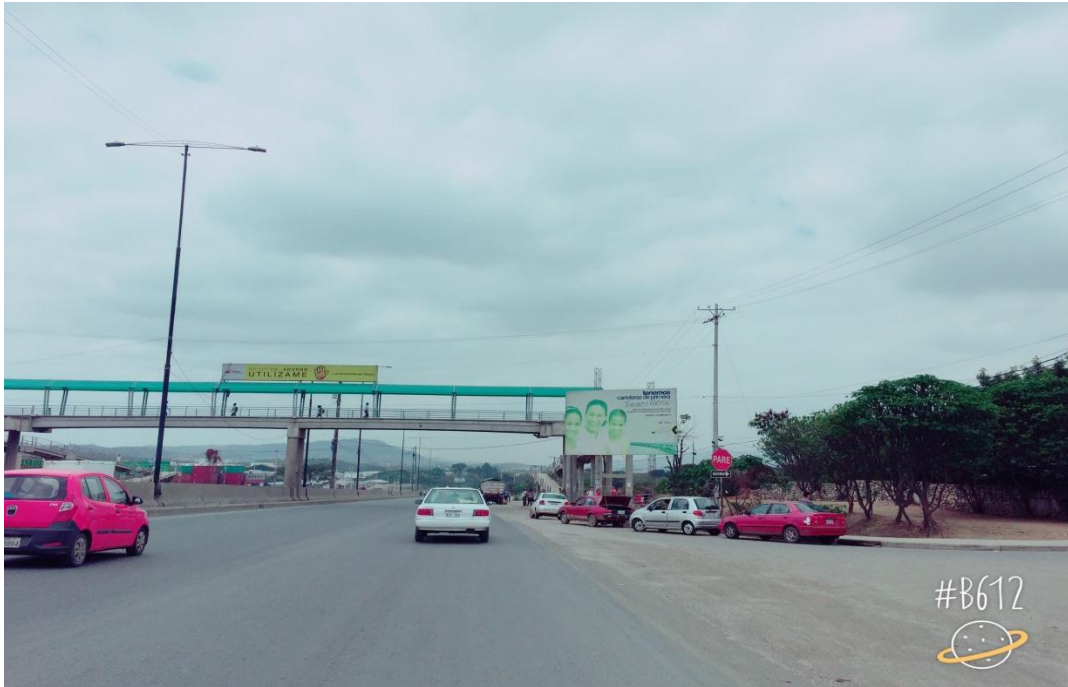
PASO PEATONAL DE LA VIA PERIMETRAL A LA ALTURA DEL HOSPITAL UNIVERSITARIO EN SENTIDO SUR HACIA EL NORTE.
