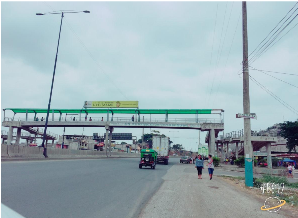
PASO PEATONAL DE LA VIA PERIMETRAL A LA ALTURA DE LA LUBRICADORA CABRERA EN SENTIDO SUR HACIA EL NORTE.
