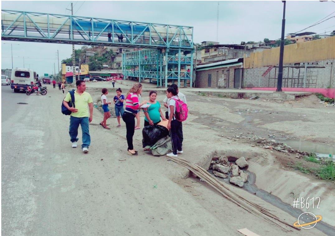
REALIZANDO LAS ENCUESTAS EN EL PASO ELEVADO ENTRADA DE LA LINEA 21.
