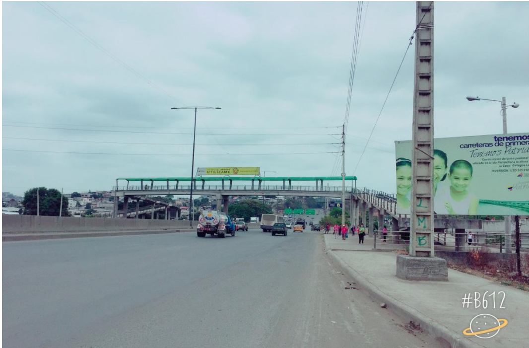
PASO PEATONAL DE LA VIA PERIMETRAL A LA ALTURA DEL GOE EN SENTIDO NORTE HACIA EL SUR.
