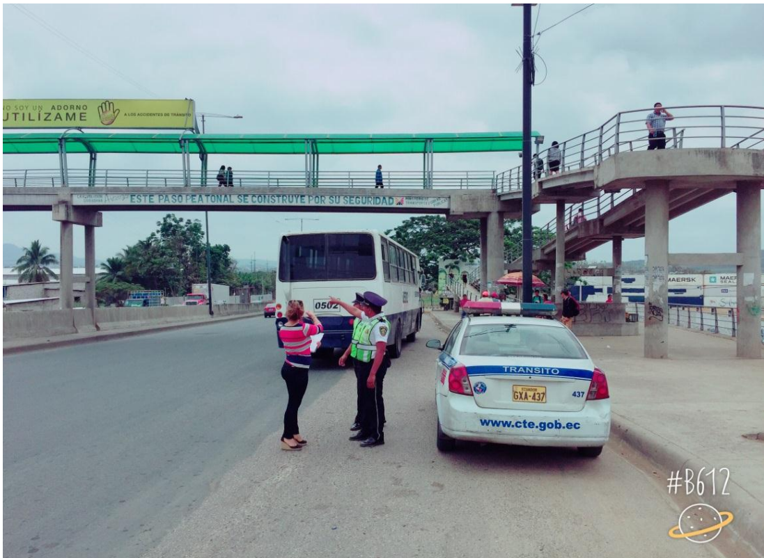
ENTREVISTANDO AL JEFE DE LA DELEGACION URBANA No. 6 EN EL PASO ELEVADO LUBRICADORA CABRERA.
