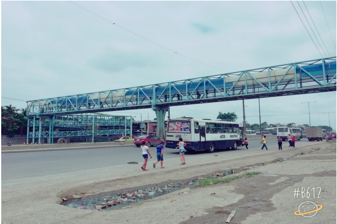
PASO PEATONAL DE LA VIA PERIMETRAL A LA ALTURA DE LA ENTRADA DE LA LINEA 21 EN SENTIDO NORTE HACIA EL SUR.
